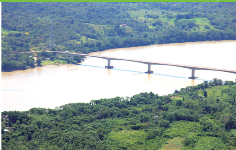
Puente Nowen sobre el río Guaviare
